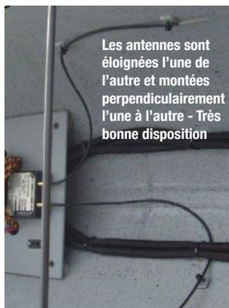
Les antennes sont éloignées l'une de l'autre et montées perpendiculairement l'une à l'autre - Très bonne disposition
